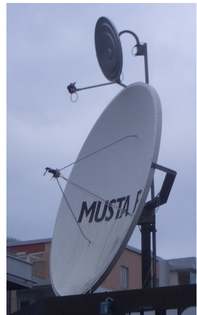
Parabólica de Fresnel con foco descentrado (arriba) y parabólica con foco centrado (abajo).
